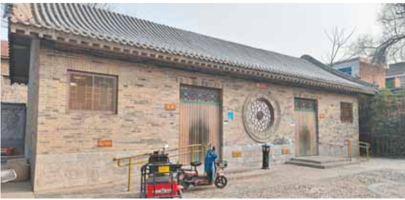
经过改造提升后的浚县古城西门公厕。
