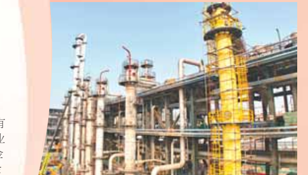
鹤壁龙宇新材料有限公司年产6万吨聚甲酯项目现场。
