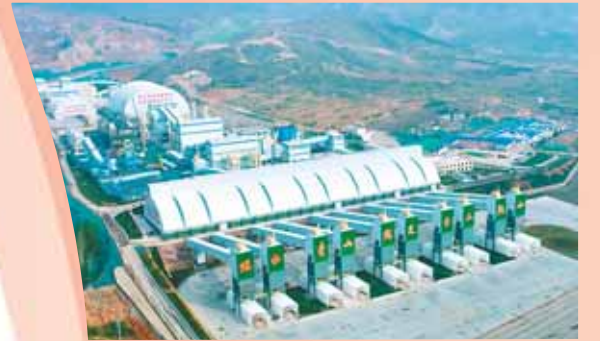
鹤壁恒源矿业集团有限公司二道庄厂区航拍图。
