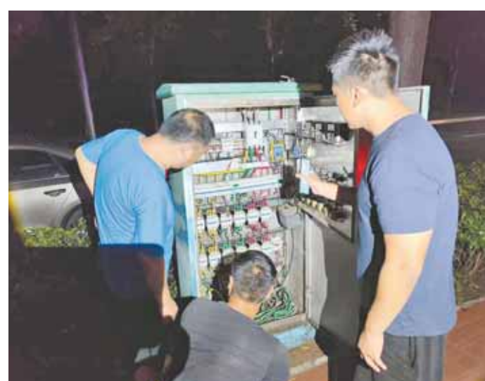
淇滨区市政建设发展中心人员对路灯景观灯供电设施水毁情况进行排查。
