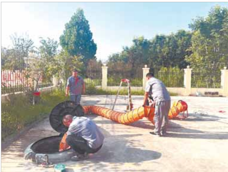
工作人员对阀门通风情况进行检测。
