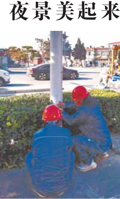
浚县城市管理局工作人员在检修线路
