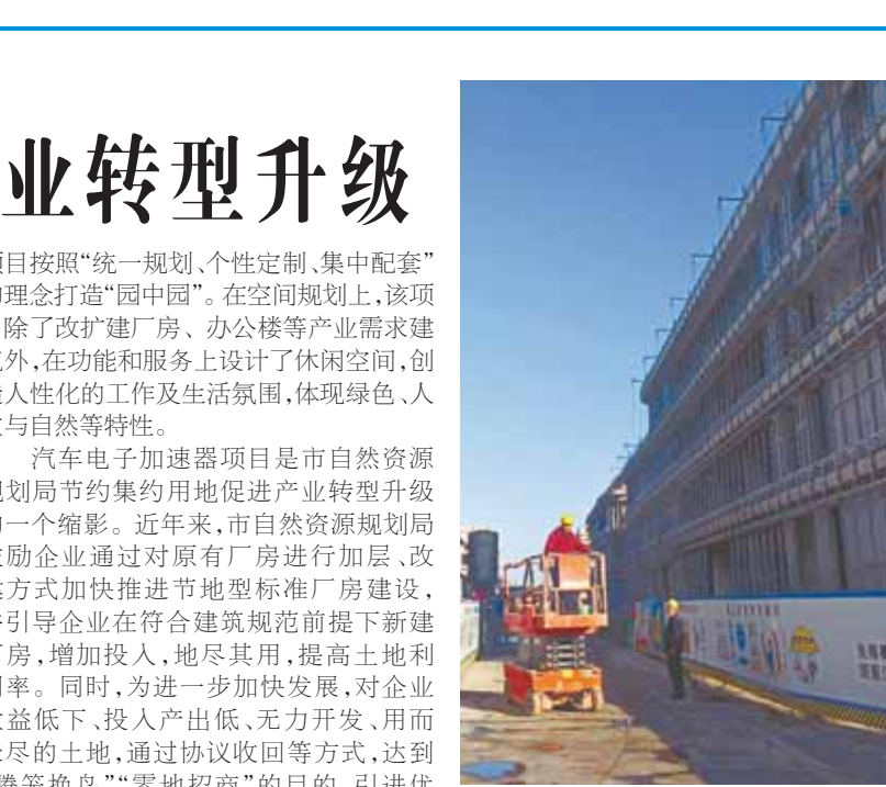
汽车电子加速器项目施工现场
