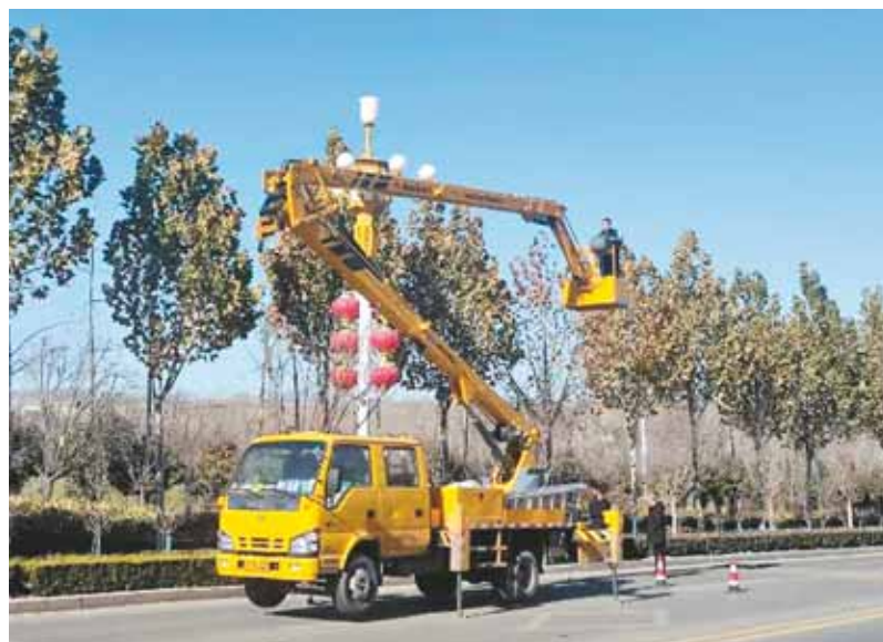
工作人员在山城路上维修路灯
