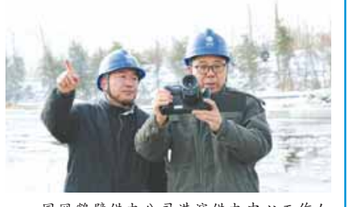
国网鹤壁供电公司淇滨供电中心工作人员使用红外测温仪对辖区“煤改电”线路进行巡视测温
