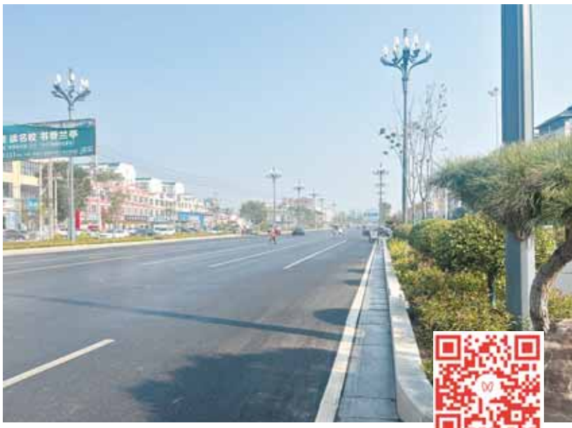
升级改造后的浚县卫河路 浚县住建局供图
