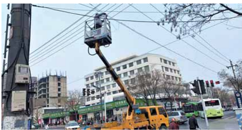
工作人员在山城区春雷路与朝霞街路口整理空中缆线 山城区市政建设发展中心供图
