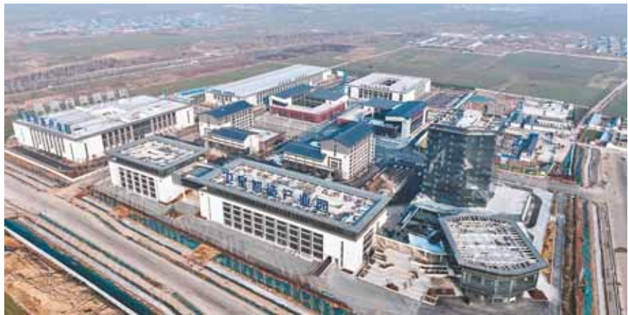
河南卫星产业园·中科星云智造基地项目
