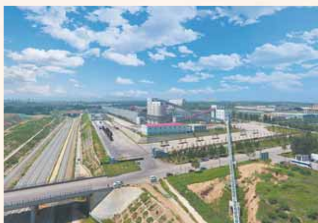
推动绿色低碳转型发展。市现代物流开发区煤炭物流园,豫煤交易中心一期煤场封闭工程主体竣工,推动煤炭物流产业转型升级,被评为2023年度全国“优秀物流园区”。
