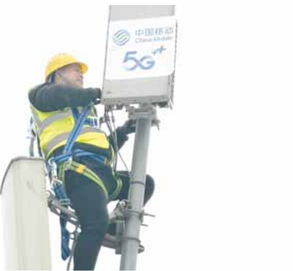
鹤壁移动公司工程技术人员在淇县西部山区安装调试5G通信基站
