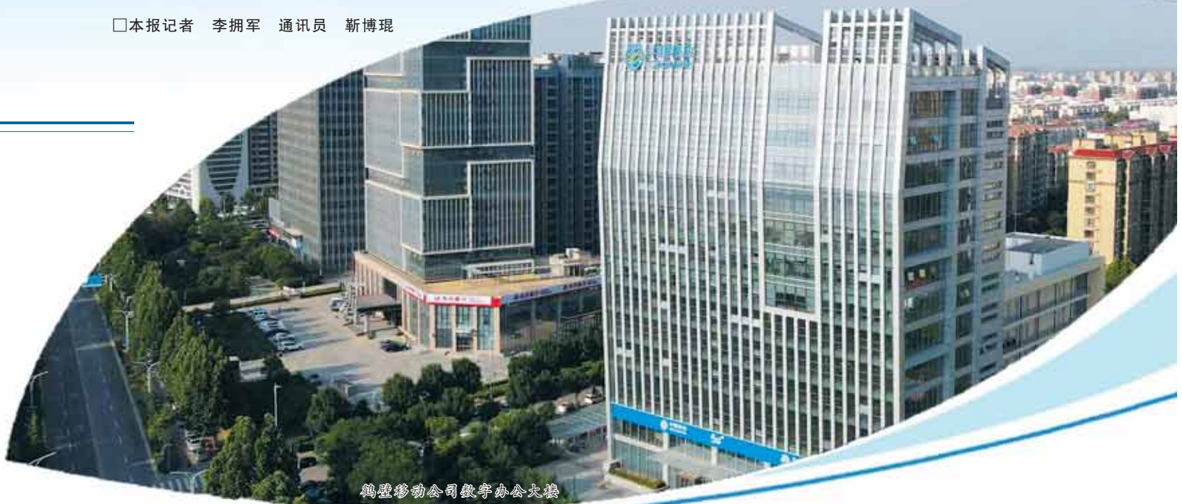
鹤壁移动公司教学办公大楼
