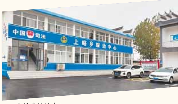
上峪乡综治中心
